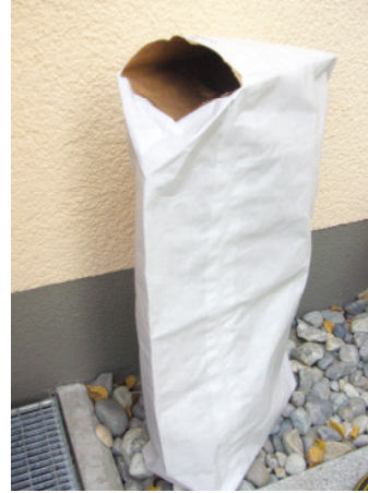
Abb. 4.16. Befüllung über Einblasen
